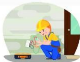
Lắp đặt hệ thống điện, nước
